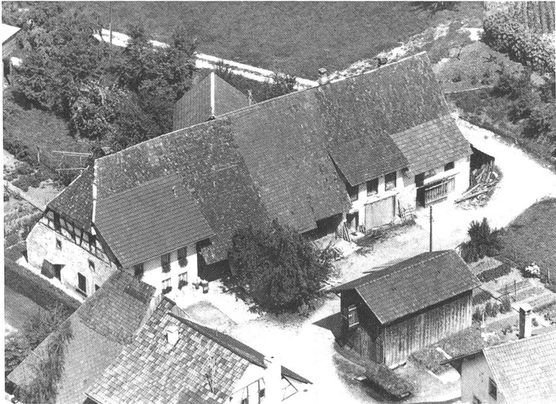
Abb. 17: Flugaufnahme aus südwestlicher Richtung (Foto: Privatbesitz).
