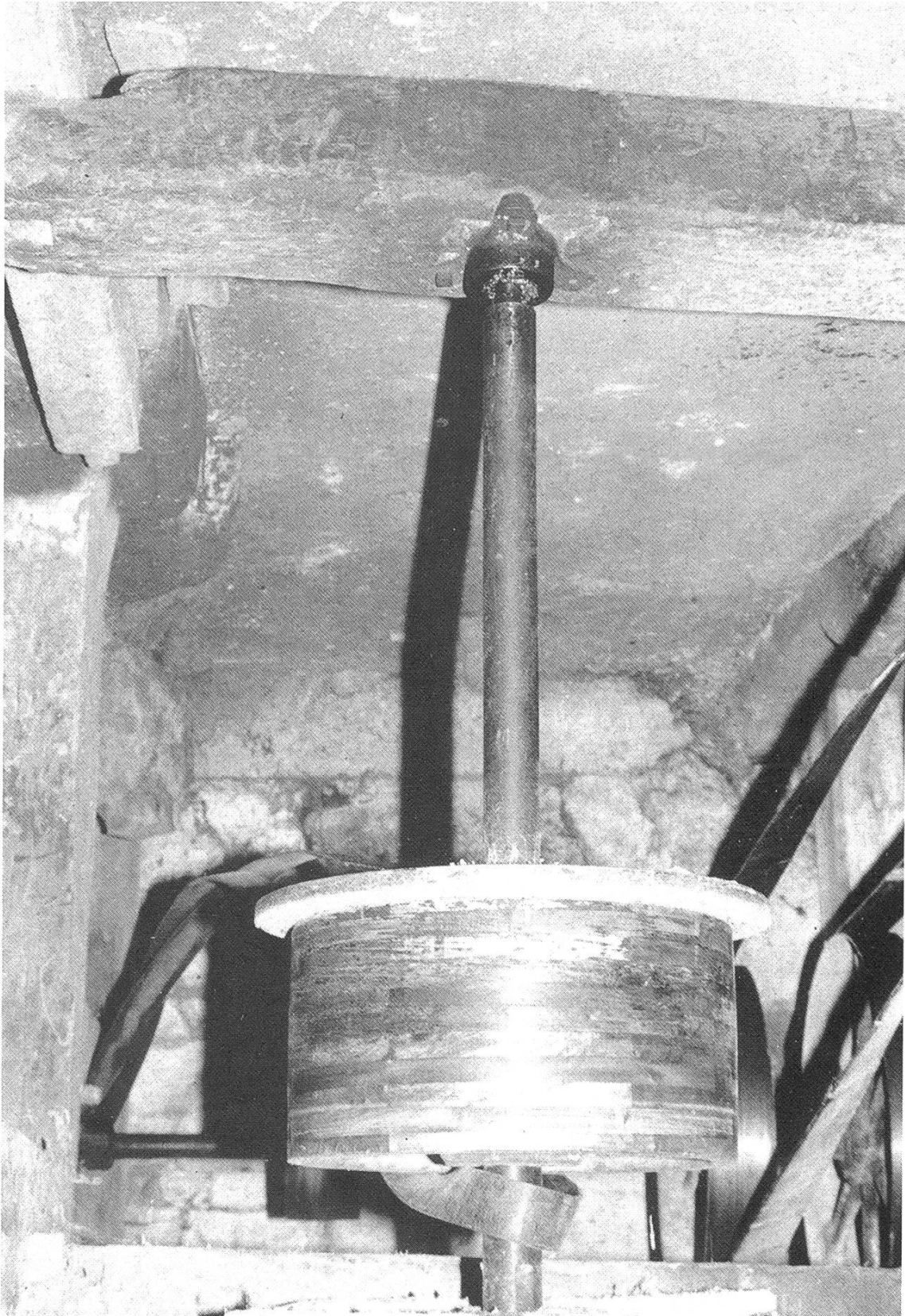
Kraftübertragung auf den Röndelstein in der Gansinger Mühle: Senkrechte Welle mit hölzernem Treibrad.
