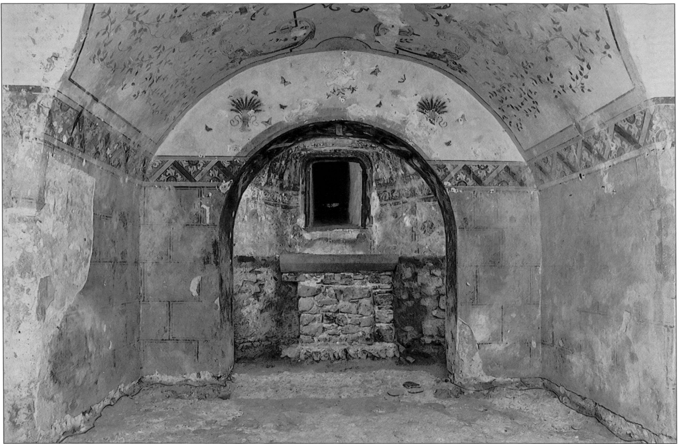
Abb. 3 Mittelraum der Krypta mit Blick nach Osten: Triumphbogen und Altar von 1360. Zustand nach Entfernen der jüngsten Sandstein- Bodenplatten.
