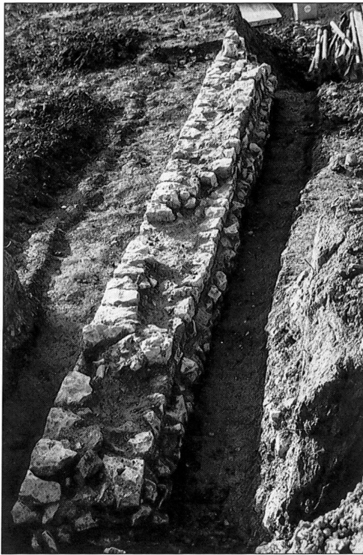
Abb. 8 Die noch auf einer Länge von 8 m erhaltene römische Mauer, Ansicht von Osten.
