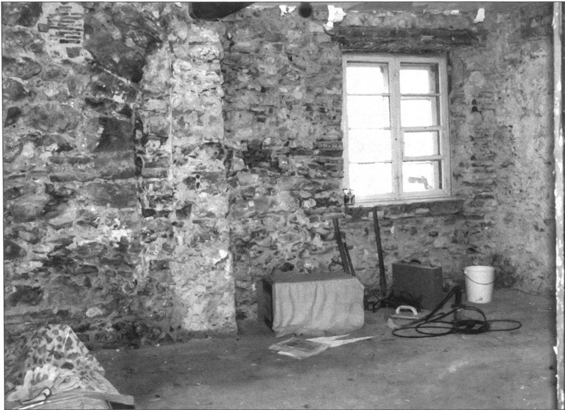
Abb. 5 St. Gallenkapelle 1988, ehemaliger Kapelleneingang, Westseite.
