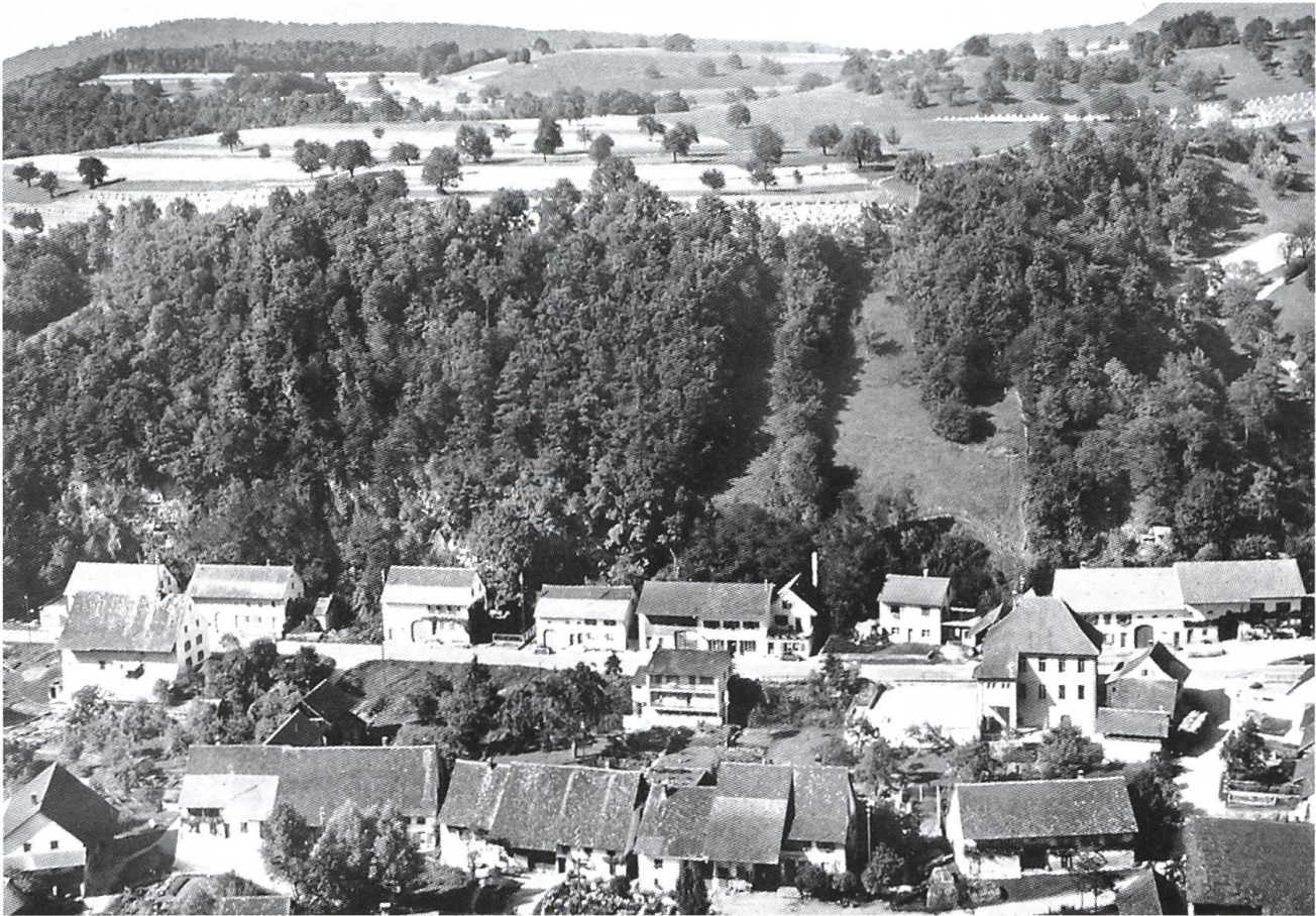
Abb. 3: Ueken CH. Der Ausschnitt zeigt im Vordergrund die bis Ende 18. Jh. durch Bauverdichtung entstandene geschlossene Häuserzeile, die in gekrümmter Anordnung dem Verlauf des Dorfbachs folgt. Im 19. Jahrhundert entstand darüber entlang der neu gebauten Staffeleggstrasse eine lockere Zeile von Neubauten. (Bild: Archiv David Wälchli, Ueken CH)
