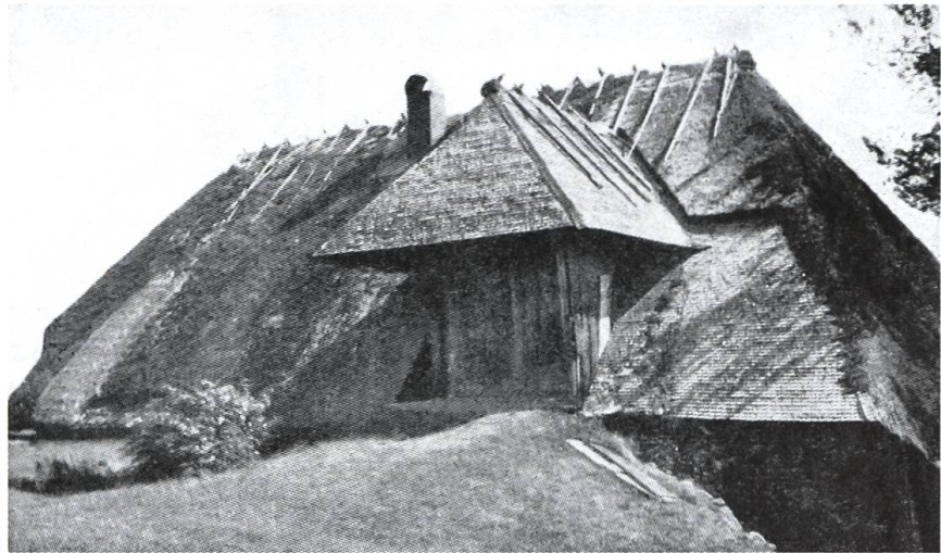
Abb. 6: Oberweschnegg DE. Rückseite eines strohgedeckten Hauses mit dem für den Hotzenwald typischen Einfahr. Der schindelgedeckte Querfirst wurde erst nachträglich angefügt und wirkt hier auch eher wie ein Fremdkörper. (Bild: Hochrhein und Hotzenwald. Badische Heimat 9 [1932])
