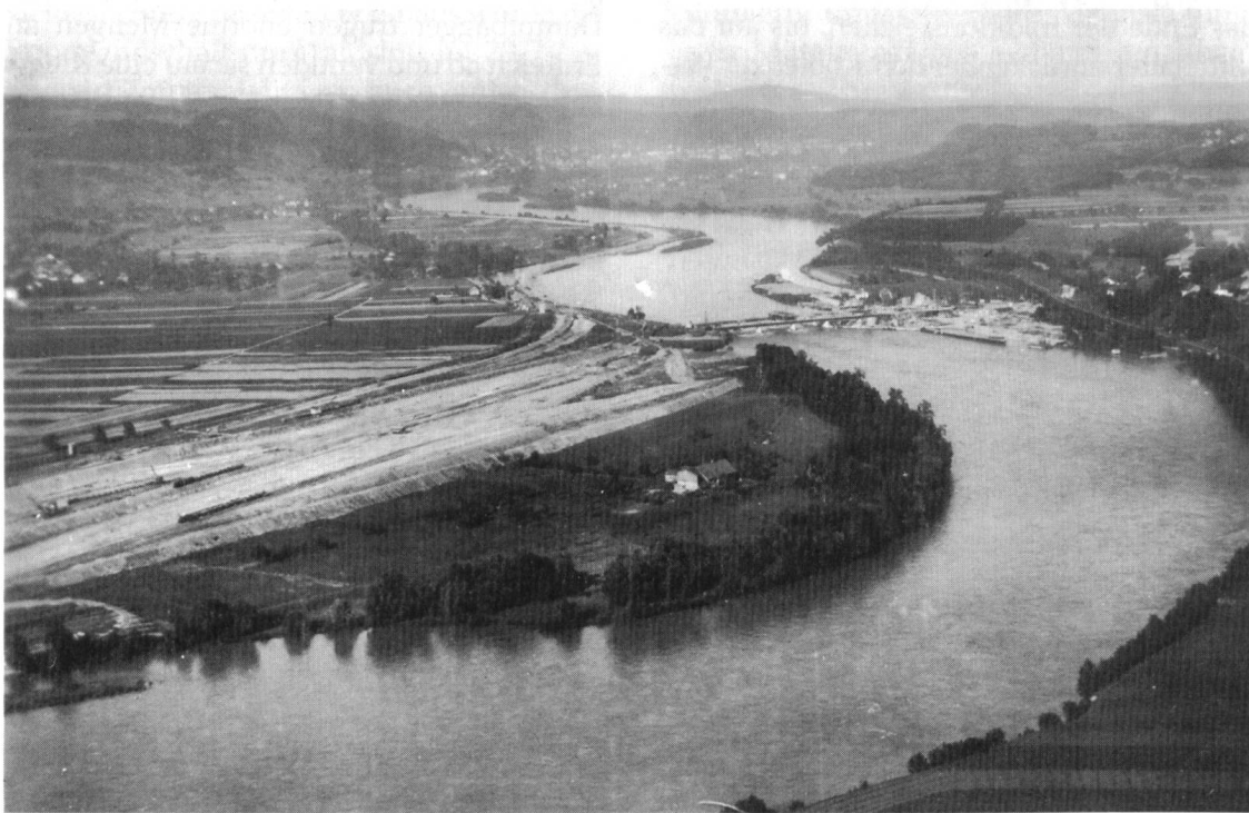
Abb. 9 Veränderung der Rheinlandschaft bei Waldshut durch den Kraftwerkbau, Anfang der 1930-er Jahre.
