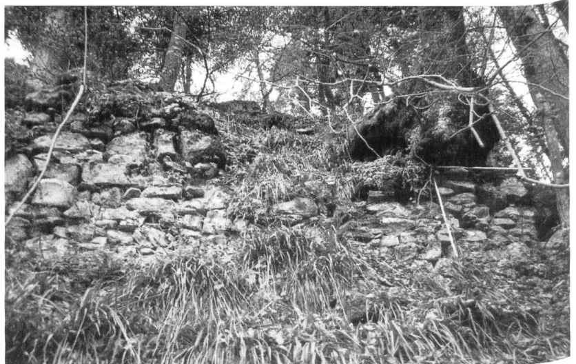
Abb. 3 Nordende der Terrassenmauer der «Vorbürg». Deutlich ist die Gefährdung durch die grosse, schräg stehende Linde zu erkennen.
