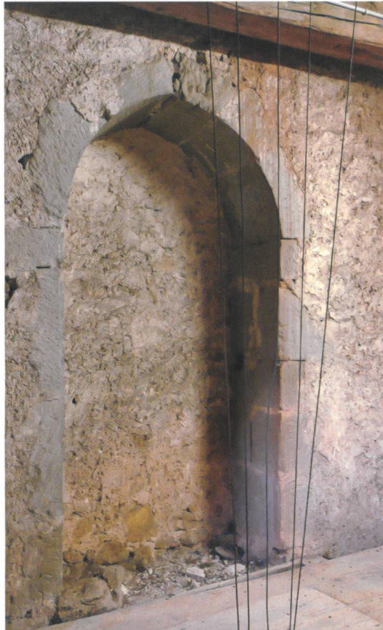
Abb. 24 Kirche Hornussen. Aussen zugemauerte ehemalige Schallöff- nung im 4. Turmge- schoss. (Edith Hunziker)
