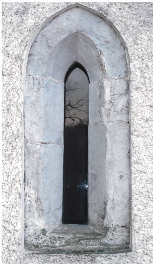
Abb. 5 Kirche Hornussen. Turmerdgeschoss, Ostseite. Schlitzförmige gotische Fensteröffnung aus dem 14. Jahrhundert mit breit gekehltem Spitzbogengewände. (Edith Hunziker)
