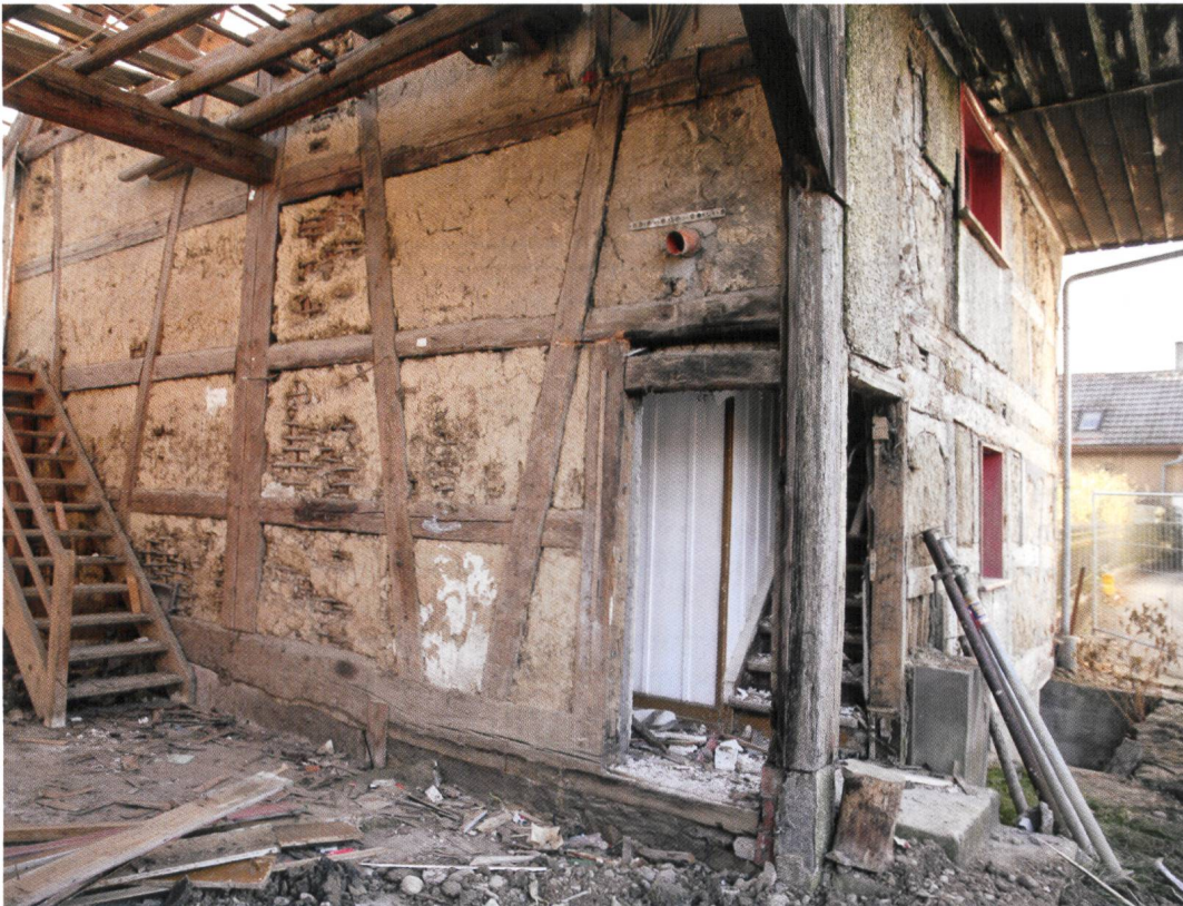
Abb. 4 Nordwestfassade und Trennwand zwischen Wohntrakt und Tenne während des Ab- bruchs. Während die Nordfassade stock- werkweise abgebun- den war, wies die Trennwand durchge- hende Ständer auf.
