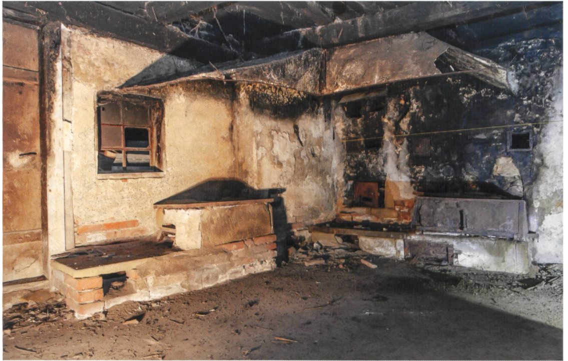
Abb. 3 Die im 19. Jh. zum letzten Mal renovierte Küche im «Dahlhaus» von 1560 in Hausen bei Brugg. (B. Polyvás)
