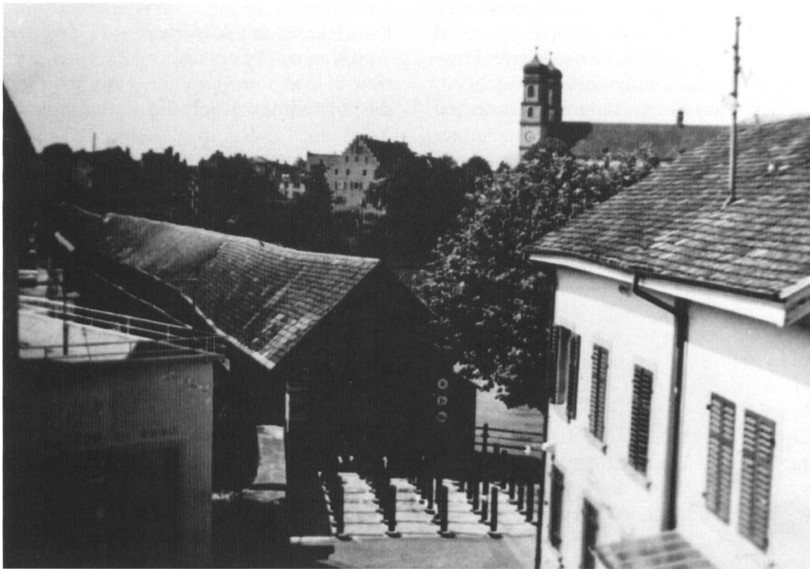
Abb. 11 Panzersperre vor der Brücke in Stein 1939.
