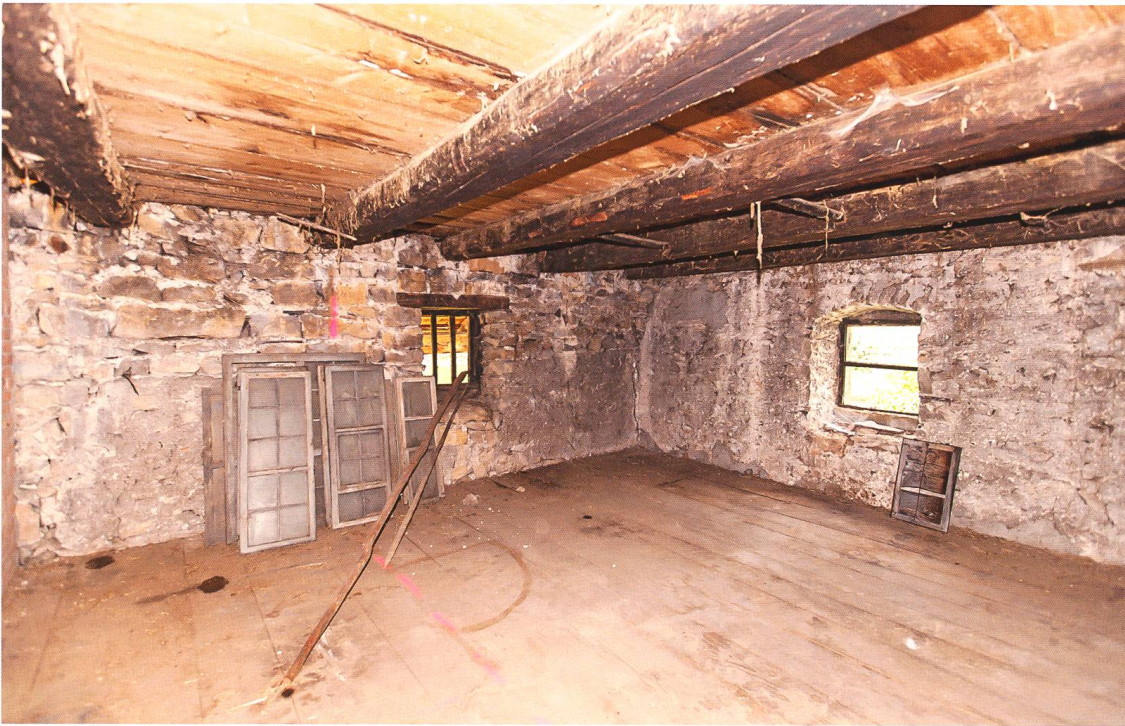
Abb.9 Wirtschaftskammer R 1.4 im Obergeschoss. Rechts Giebelwand M1, links Rückwand M2 mit dem vergitter- ten Fenster.
