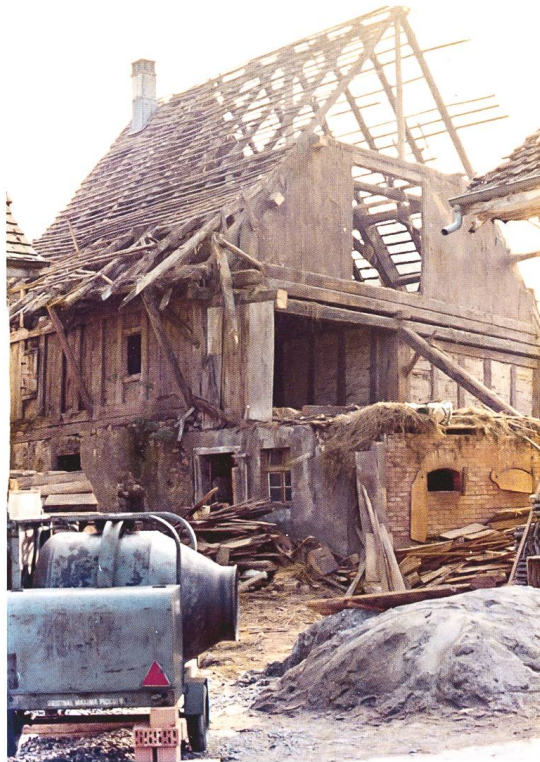
Abb. 11 Kirchstrasse 5: Der Anbau von 1698 mit steinernem Stock und hölzernem Überbau.
