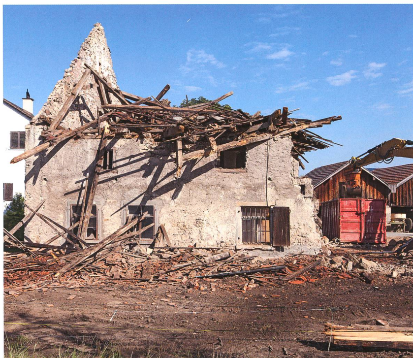
Abb. 1 Die Rückseite des Gebäudes während des Abbruchs.
