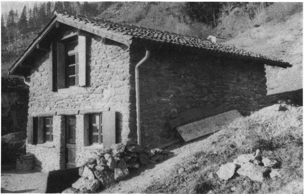
Fig. 8 et 9 Constructions rurales de montagne au Val Colla (Tessin) restaurées, avec pierres d'origine locale mises en évidence. La diversité des formes et des teintes des blocs, ainsi que la texture des murs à ras de pierres ou avec blocs en saillie, montrent l'ancienne technique paysanne et respectent le paysage humanisé par l'agriculture de montagne.
