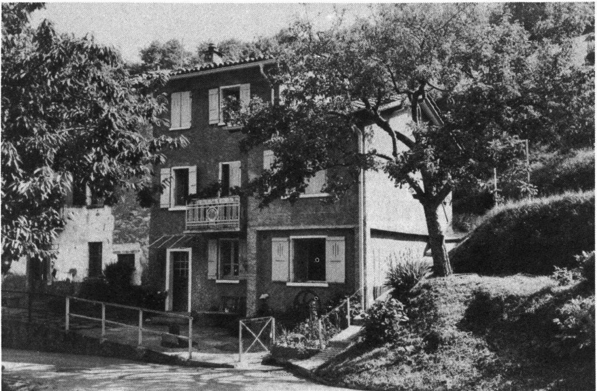
fig. 3 Illustre l'équilibre de la maison de montagne du Val Colla, sa sobriété, ses bonnes proportions. A droite de la maison, le terrassement agricole des moraines, dont le nouvel angle de repos est de 70^\circ , sans rupture ou éboulement des talus (Photo B. Campana).
