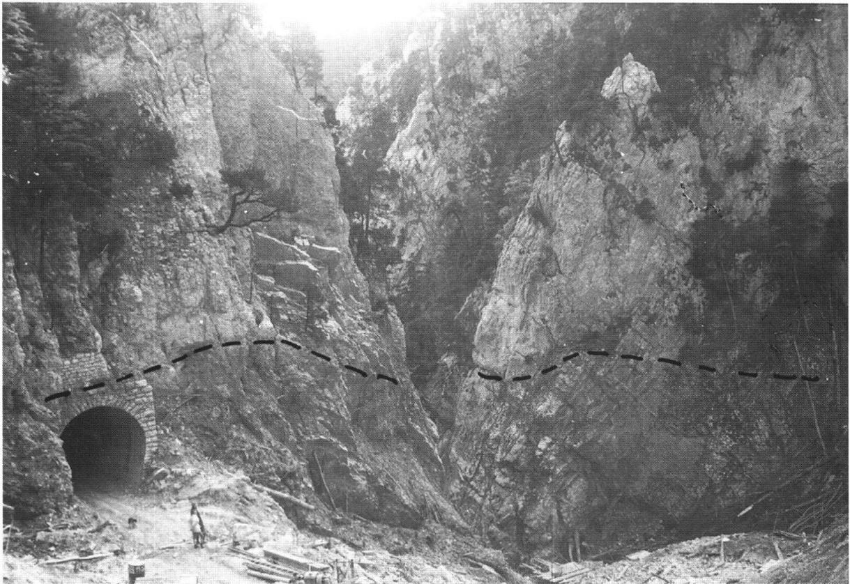
**Fig. 3:** Die Lochbachklamm und der Strassentunnel nach der Räumung, Sicht von Norden. Die gestrichelte Linie bezeichnet die Höhe der Ablagerungen vor dem Murgang (Foto H. Fröhlicher, 1. November 1970).
