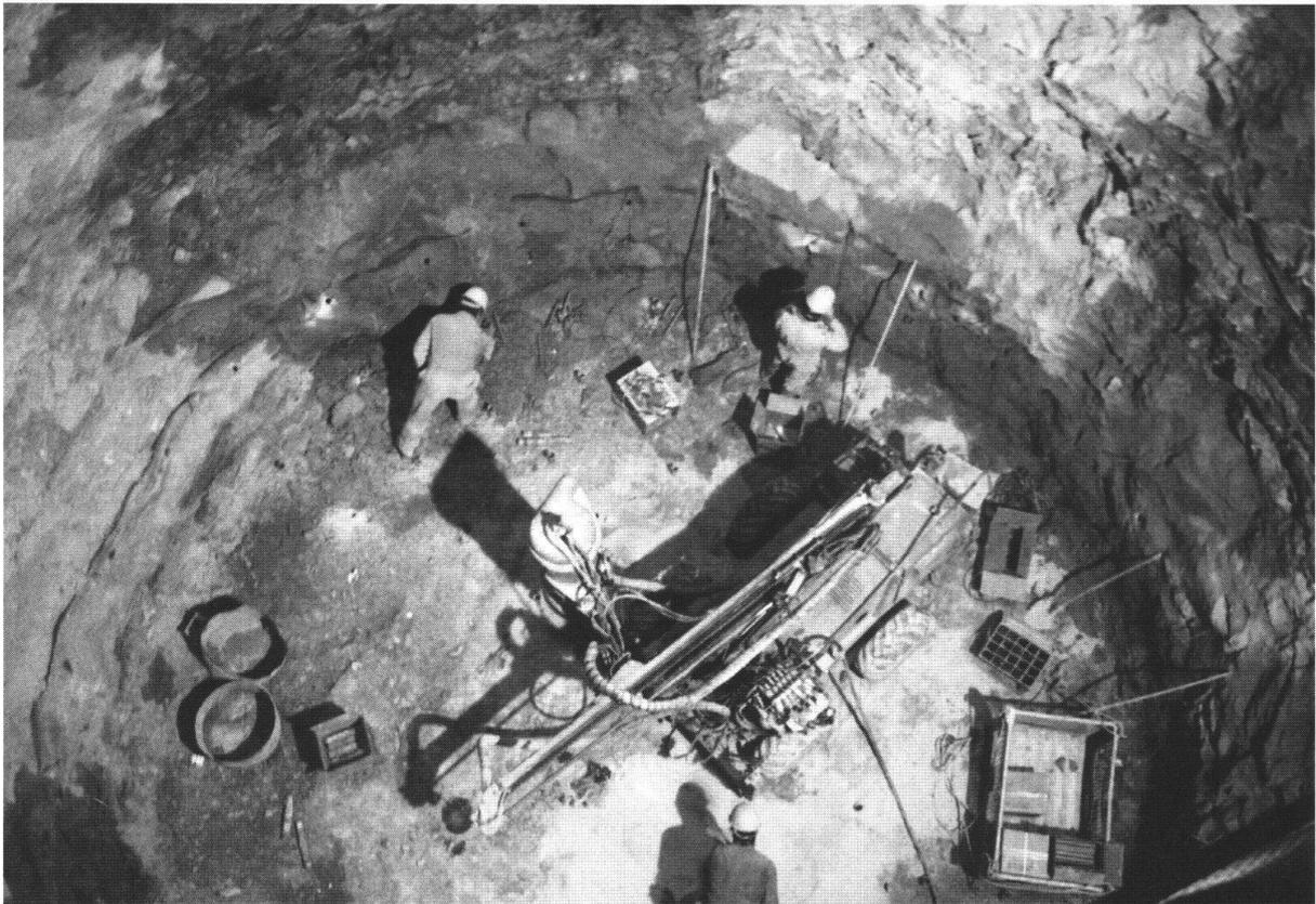
**Fig. 3:** Bohrungen für den Sprengvortrieb im Schacht Lyren (Aufnahme S. Mützenberg).
