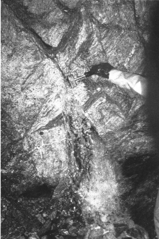
Fig. 6: Wasserführende Kluft im Sondierstollen Silz.
