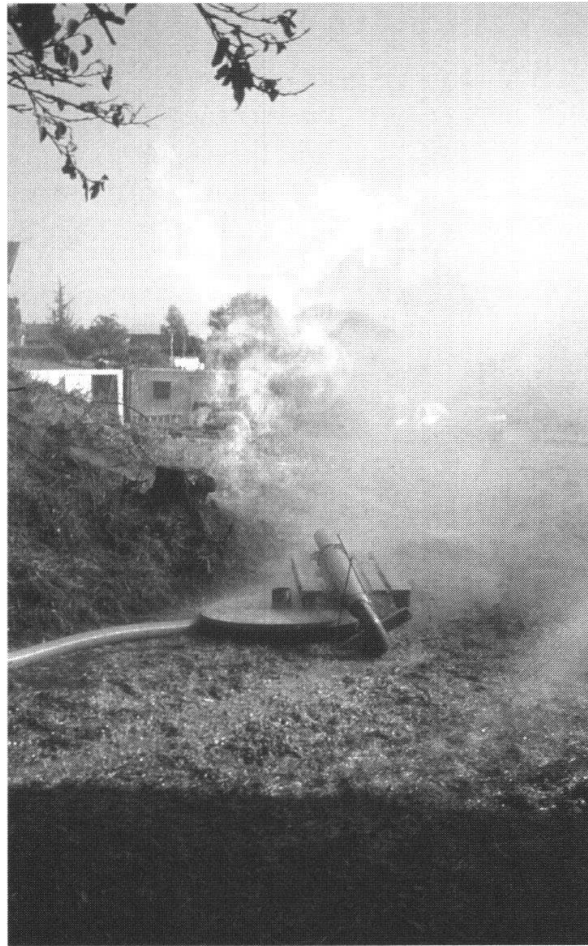
Fig. 3: Über die verlängerte Spülungsleitung wurde das Gas, in eine aus einem Futterrohr improvisiert hergestellte Fackel, abgeleitet. Das Futterrohr ist auf einem beschwerten Holzrahmen festgebunden und somit fixiert. In diesem Zustand gab es keine Möglichkeit, den Gasfluss zu stoppen.
