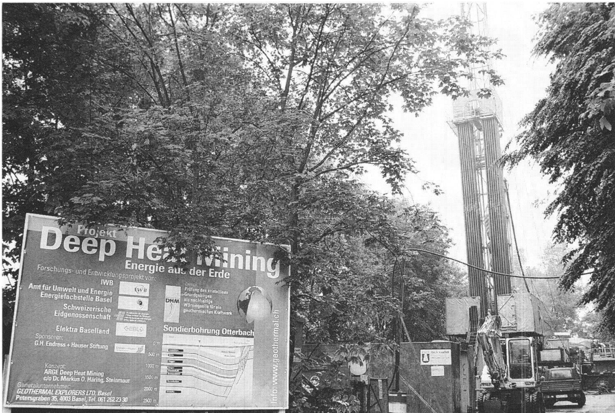
Fig. 2: Bohrung Otterbach 2, Basel.
