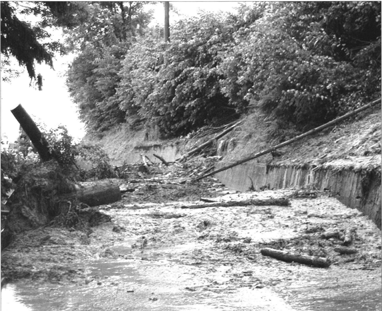
Fig. 1: Düninflüssige Murgangablagerungen (Mure Nr. 1 im Vordergrund, Mure Nr. 2 im Hintergrund) mit viel Sturmholz auf der viel befahrenen Kantonsstrasse Littau/Malters-Kriens.
