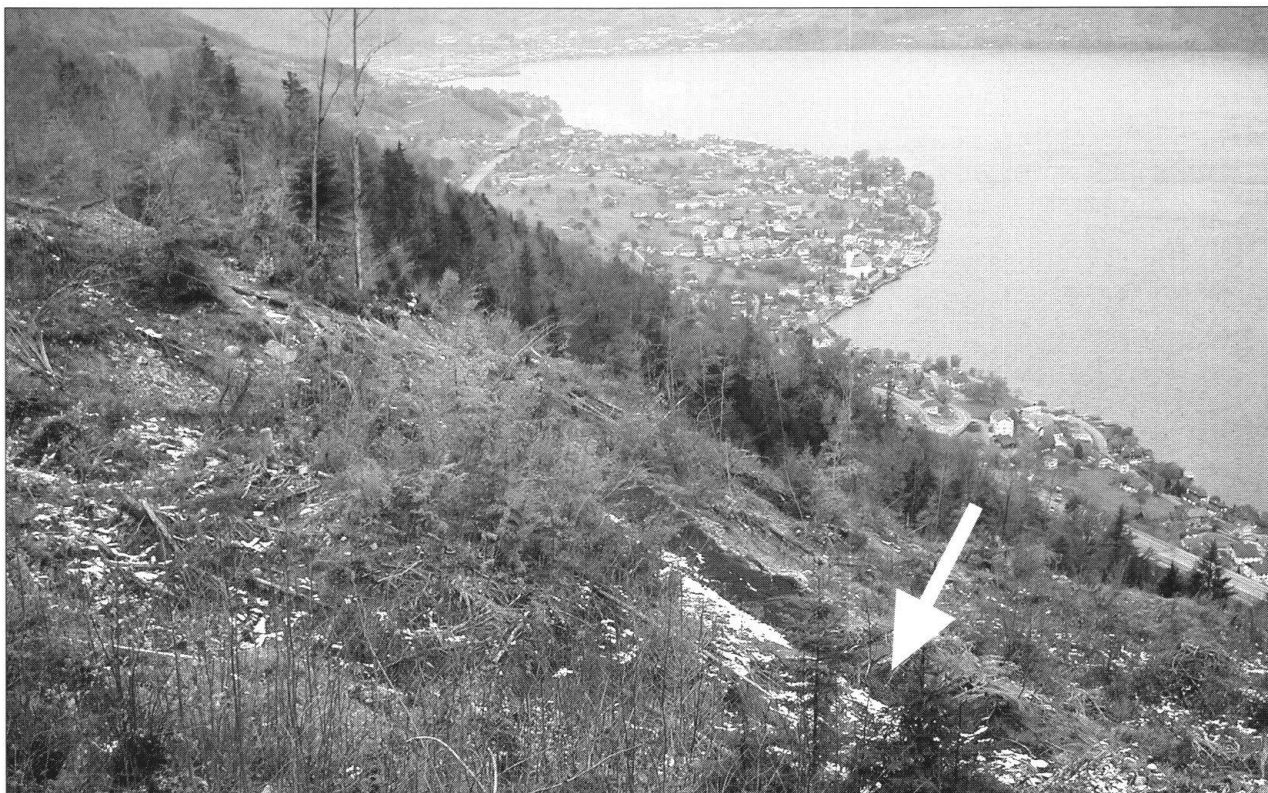
Foto 1: Tiefblick auf das Rutschgebiet Ischenwald ob dem Vierwaldstättersee. Die Lage der abgerutschten Strasse (Pfeil) zeigt das Ausmass der Differenzialbewegungen an. (Foto: S. Löw)
