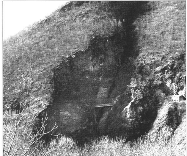
Fig. 1: Die Brücke Val d'Infern als Verbindung zweier Tunnel quert eine geologische Störzone.
