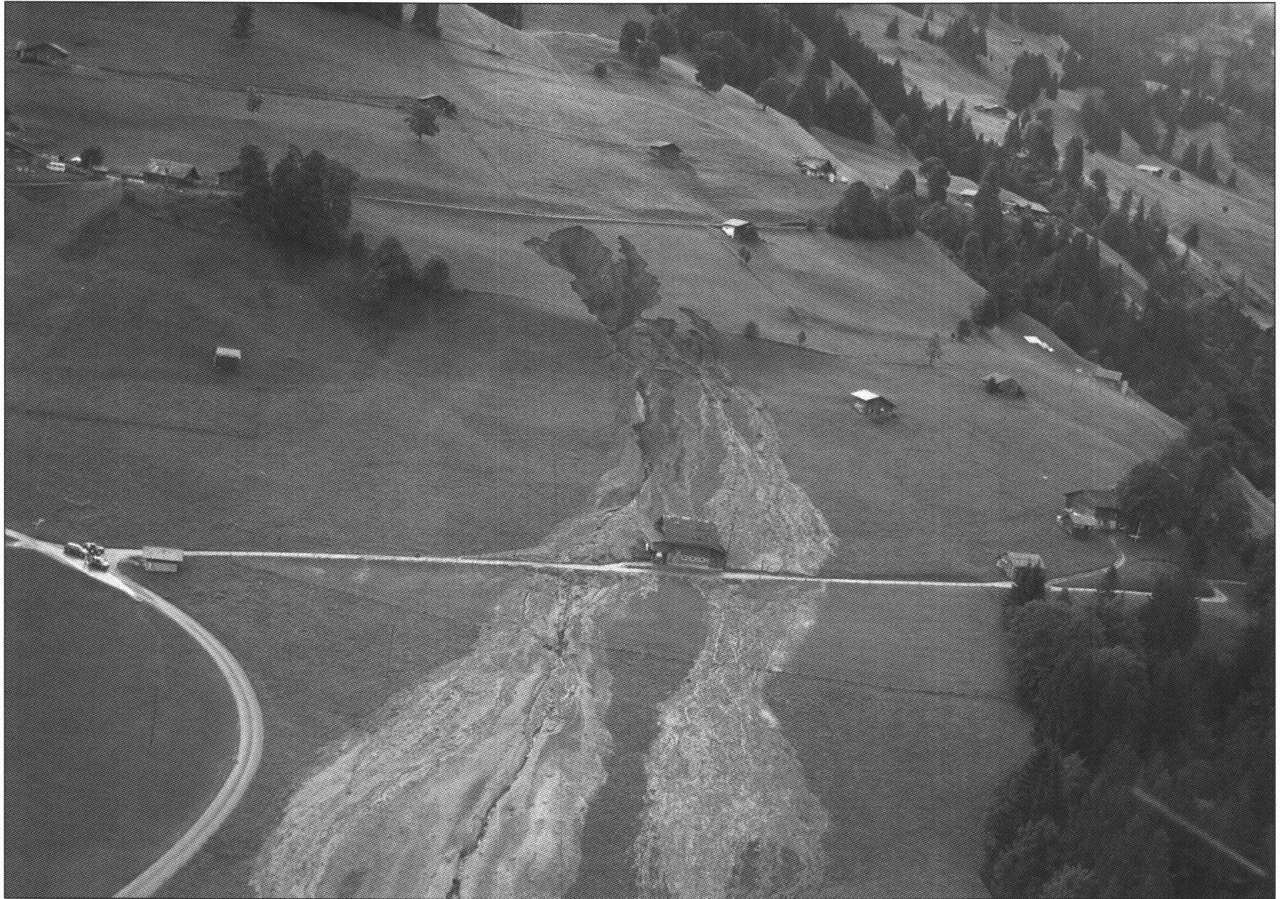
Fig. 8: Erosionsgräben (obere Bildmitte) und übermurtetes Gelände im Gebiet Hanebüel-Riedere. Zwischen den beiden Hauptübermurtungsflächen liegt ein Stall, der von den Erdmassen getroffen wurde. Die Strasse nach Walkli verläuft etwas unterhalb der Bildmitte. Luftaufnahme vom 26.8.2005.
