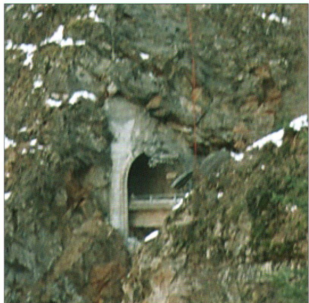
Fig. 7: Das Tunnelportal wurde innerhalb der letzten 3 Stunden stark deformiert [Zeitpunkt vor dem Absturz: oben links 2\frac{3}{4} h, oben rechts 1\frac{1}{2} h, unten links \frac{3}{4} h, unten rechts \frac{1}{2} h].
