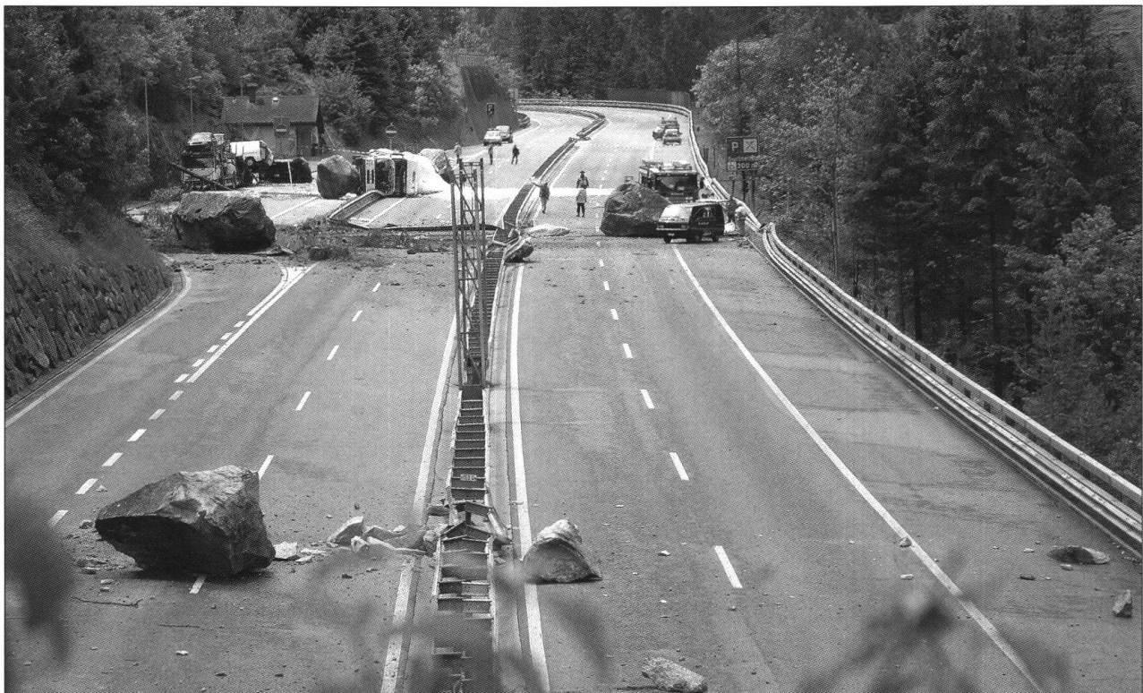
Fig. 9: Felssturz Gurnellen, 31. Mai 2006 (Foto Kantonspolizei Uri). Grossblöcke mit Kubaturen zwischen 6 und 60 m 3 erreichten die Autobahn oder stürzten sogar noch über diese hinaus. Daneben lagen viele Splitterblöcke auf der Fahrbahn.
