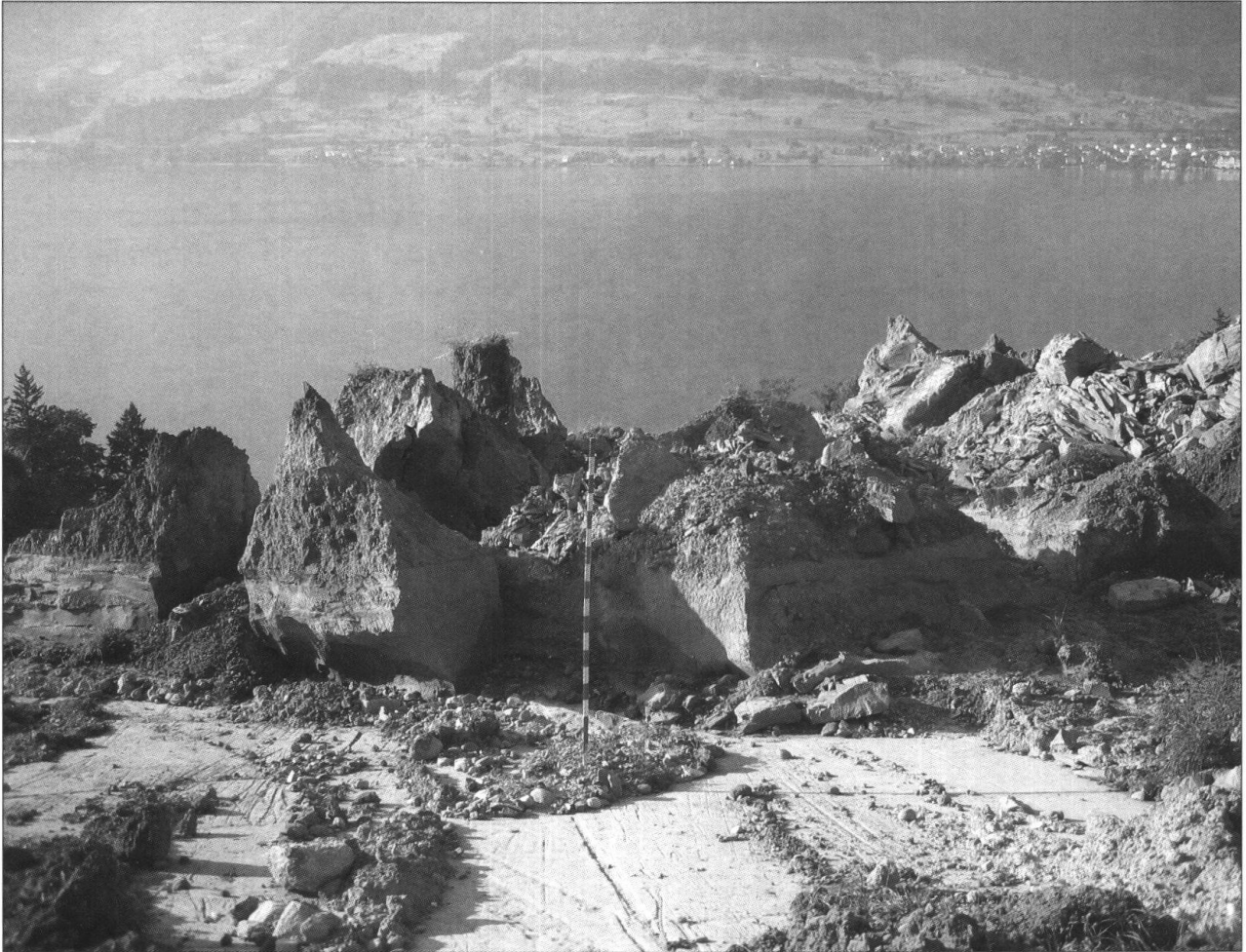
Fig. 7: Detail der Hangmure/Felsrutschung Buochli, Ennetbürgen (Ereigniskataster Nidwalden, Foto Oeko-B AG). Deutlich erkennbar ist, dass die Bewegung nicht an der Grenze Lockergestein/Fels erfolgte, sondern innerhalb des Felsens.
