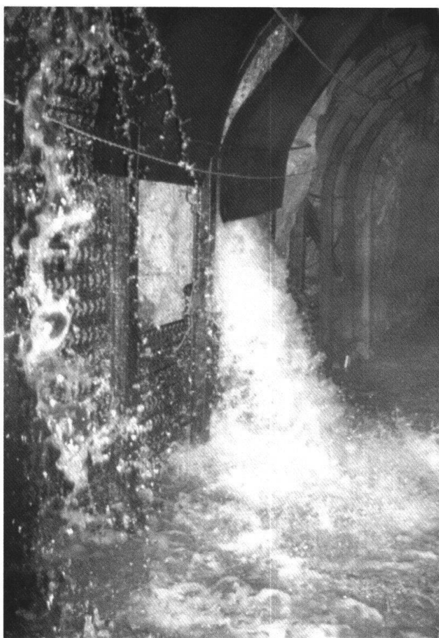
Fig. 8: Ergiebige Karstwassereintritte in den Sondierstollen aus Schichten im Oberen Twannbachkalk.
