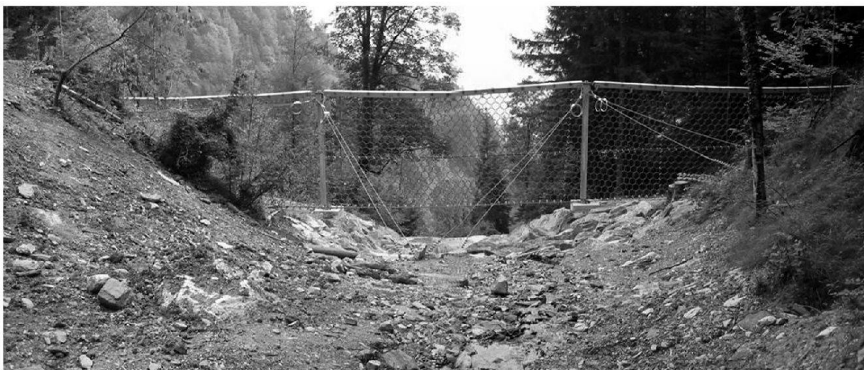
Fig. 2: Filet dynamique de retenue contre les laves torrentielles à Vorder Ritzgraben.
