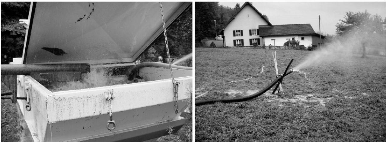
**Fig. 3:** Erdgasaustritt vor der kontrollierten Entzündung. Links: Ausblasen über die Absetzmulde in die Absetzmulde für Bohrklein. Rechts: Verlängerte und umgelegte Spülungsleitung auf das freie Feld.
