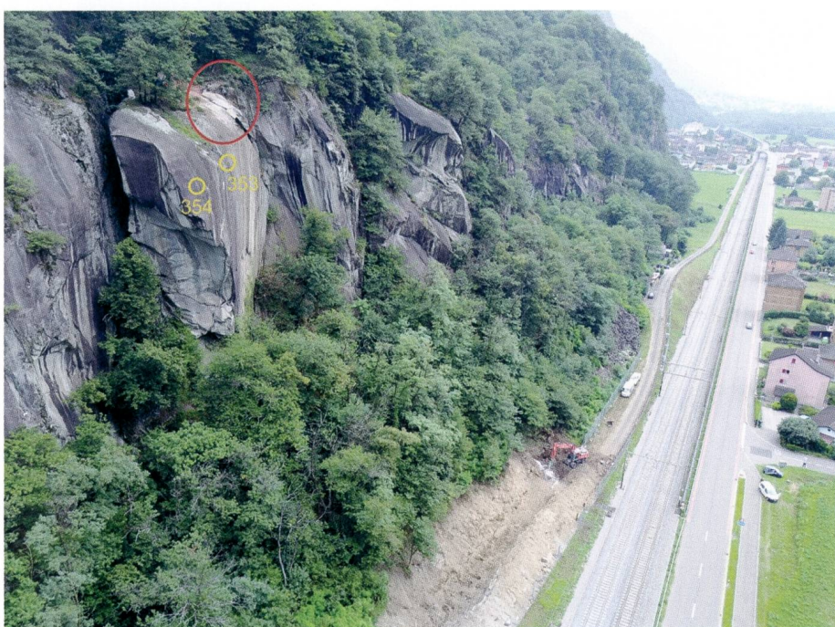
Fig. 2: Foto aus der Luft in Richtung S mit dem Felsband und der SBB-Linie (rechts). Das massige, labile Felskompartiment (links) von rund 20' - 30'000 m 3 mit den instabilen Felsplatten im Kopfbereich (roter Kreis) ist im Norden durch eine weit offene Kluft vom stabilen Felsverband abgetrennt. Vorne am grossen Felspaket sind die beiden Messpunkte Nr. 353 und Nr. 354 für die tachymetrische Felsüberwachung montiert (gelbe Kreise). Das Foto wurde während den Vorbereitungsarbeiten zur Sprengung gemacht.
