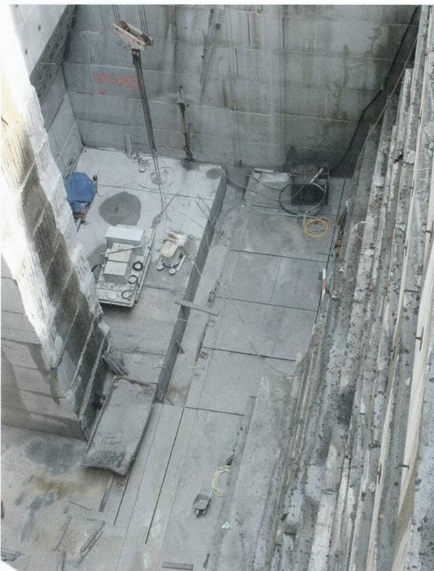
Fig. 5: Blick in die Sohle von Schacht 5/6 mit unterschrittener Nord- (links) und abgetreppter Südwand (rechts) sowie Stütze aus gewachsenem Fels.
