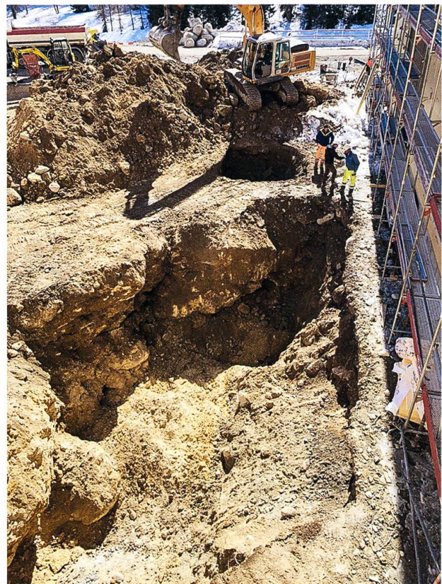
Fig. 13: Das zuletzt vorgefundene Höhlensystem in der vierten Etappe. Rechts im Bild ein bereits fertiggestellter Teil der neuen ARA (Bild M. Berweger, 22.03.2019).
