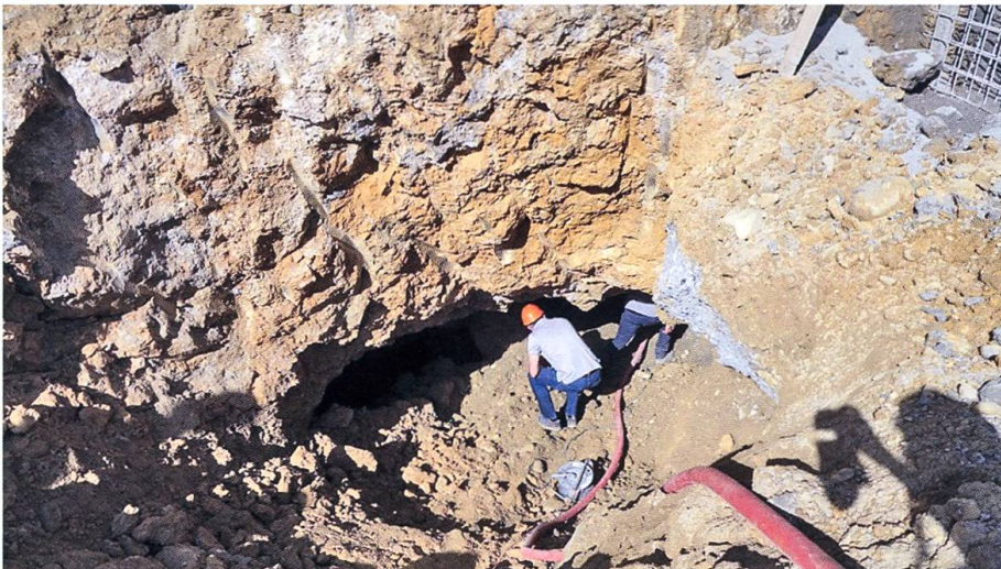
Fig. 5: Freigelegter Zugang zum Karsthohlräum (Bild Th. Rüegg, 04.08.2017).
