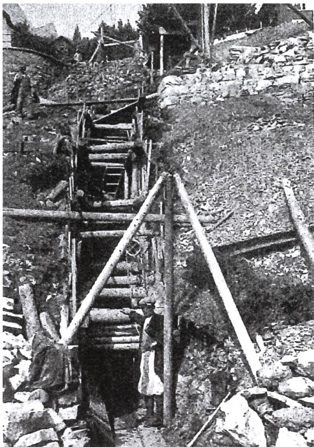
Fig. 6: Bau eines von Hand erstellten Sickergrabens neben der Bergstation der Braunwaldbahn, 1932 oder 1933 (aus Marthaler & Bolter 1934).
