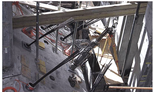
Fig. 5: Blick während der Spannarbeiten in den Ankerkeller mit den im Fundamentblock eingebauten Ankern und Extensometern.
