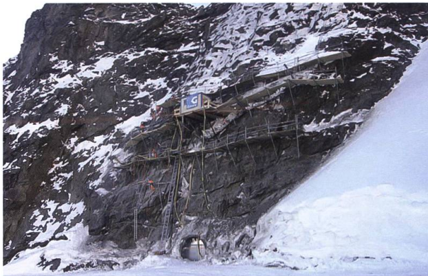
Fig. 11: Winterbaustelle oberhalb Aletschausgang zur Erstellung der permanenten Verankerungen.
