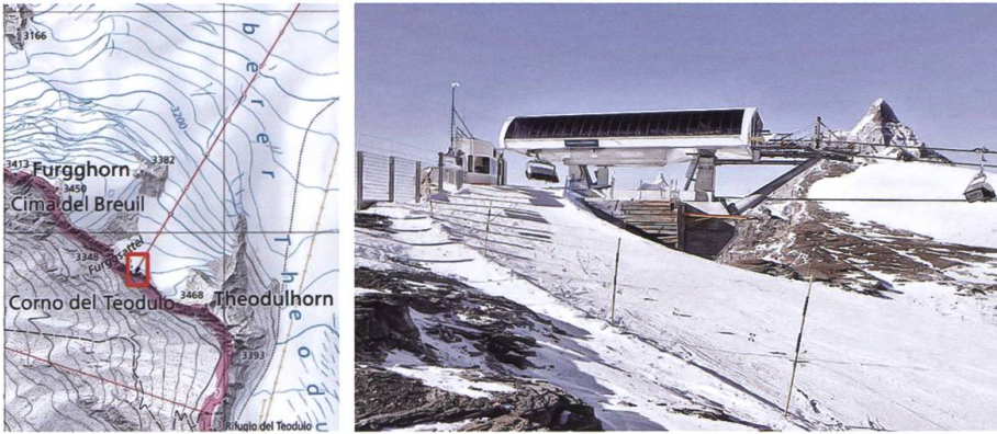
Fig. 1: Situation und Übersicht Bergstation Furggsattel lift im Betriebszustand.
