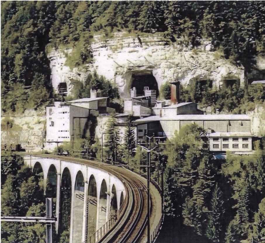
Fig. 4: Gebäude der Fabrique de Chaux von St-Ursanne, in denen das Mont Terri Projekt Anfangs 1997 Büros, Sitzungszimmer, Werkstätten und Lagerräume eingerichtet hat. Im Vordergrund der Eisenbahnviadukt von St-Ursanne.
