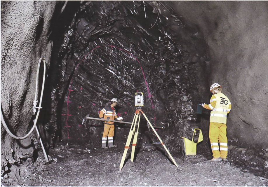
Fig. 12: Sondierstollen, Stollenmeter SM89.5. Der gesamte Stollen verläuft in Flysch. Der Vortrieb des Sondierstollens erfolgt konventionell, resp. sprengtechnisch im Vollausbruch. Foto: Christoph Nänni, TBA GR.
