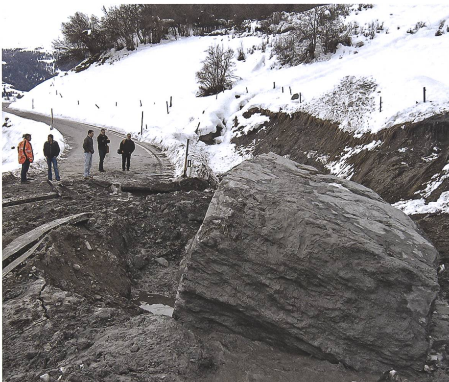
Fig. 6: Felssturz mit mehreren Grossblockschlägen bilden im Dezember 2008 den Auftakt einer bis heute anhaltenden Phase verstärkter Sturzaktivität. Die Kantonsstrasse Lenz - Brienz wurde mehrfach von Grossblöcken getroffen und musste im Jahr 2009 wegen starker Felssturzaktivität für mehrere Monate gesperrt werden. Grösse des Blockes: rund 60 m 3 . Heute sorgt eine Steinschlag-Radarüberwachung mit gekoppelter Lichtsignalanlage für ausreichende Sicherheit vor anrollenden Blöcken (Foto: Christoph Nänni, TBA Chur).
