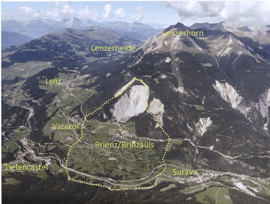
Fig. 2: Luftbild. In der Bildmitte sind die hellen dolomitischen Felsabbrüche oberhalb des Dorfes Brienz/Brinzauls auffällig. Darunter folgt die Geländeterasse mit dem Dorf Brienz/Brinzauls mit flacheren, rundlichen Geländeformen des unteren Teils der Grosshangbewegung. Foto Christoph Nänni, TBA GR.
