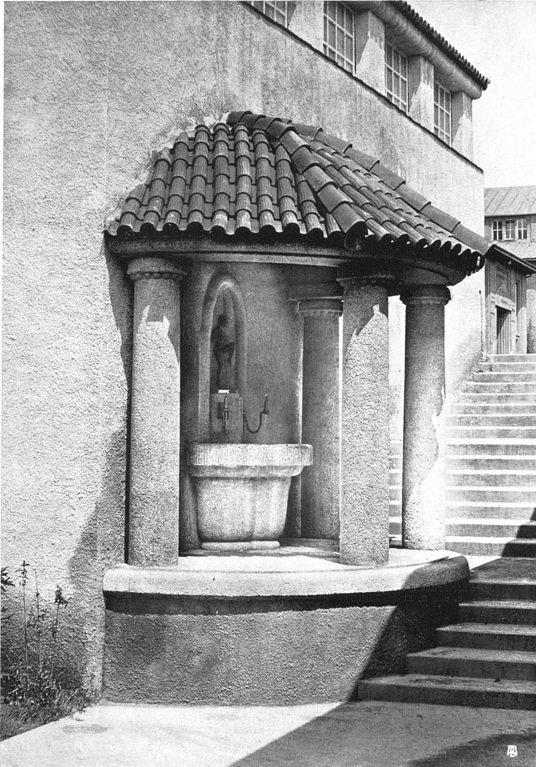
Wandbrunnen am Pavillon des B. S. A. an der Landesausstellung Ausgeführt in Kunststein von Bernasconi, Bern
