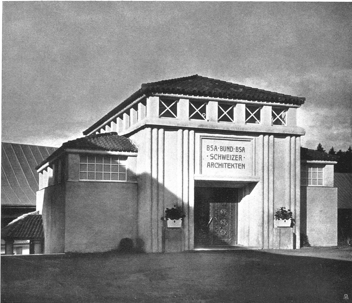
Pavillon des „Bund Schweizer Architekten“ an der Landesausstellung
