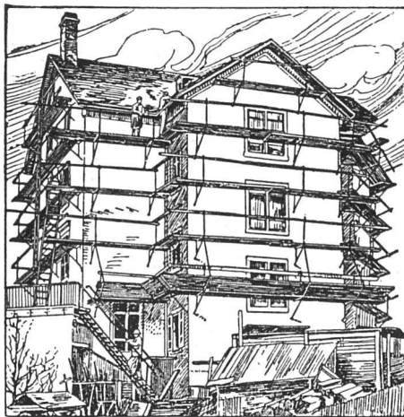
Ganz eingerüstetes Haus
