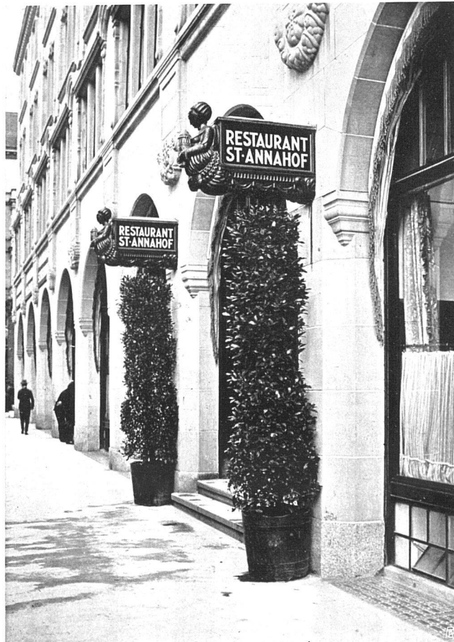
St. Annahof Zürich Fensterreihe im I. Stock. Eingang des Restaurants
