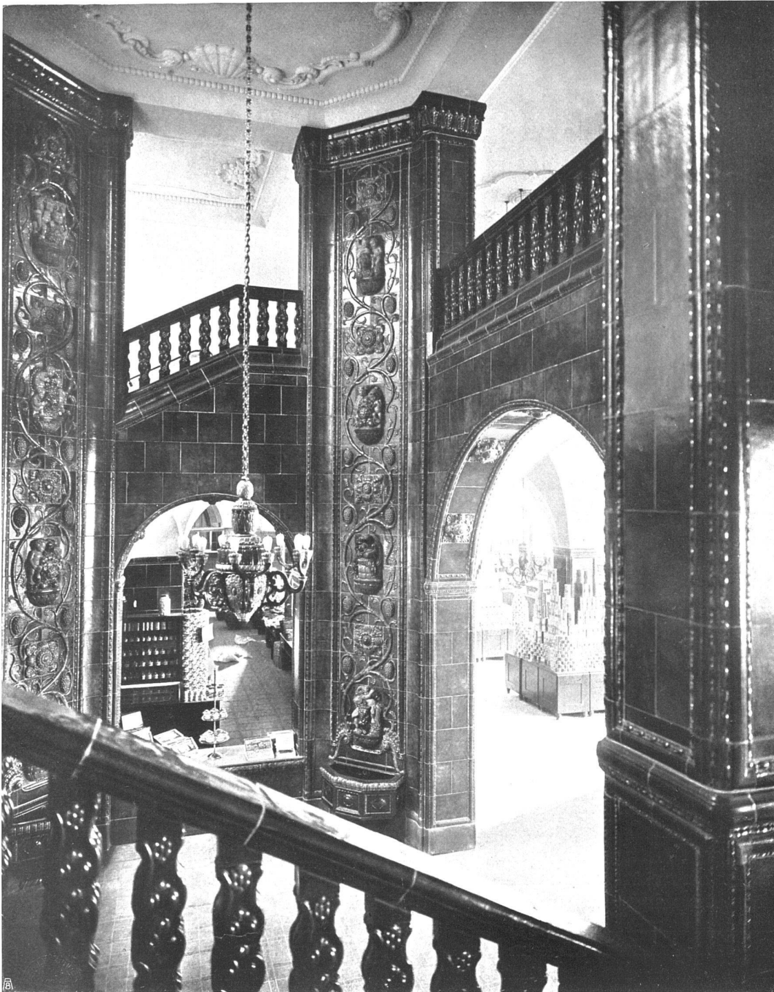
St. Annahof, Zürich. Treppenaufgang in der Lebensmittelhalle. Arch. B. S. A. Gebr. Pfister, Zürich. Ausführung in Mutzkeramik von Sponagel & Cie., Zürich. Plastik von Otto Münch, Zürich
