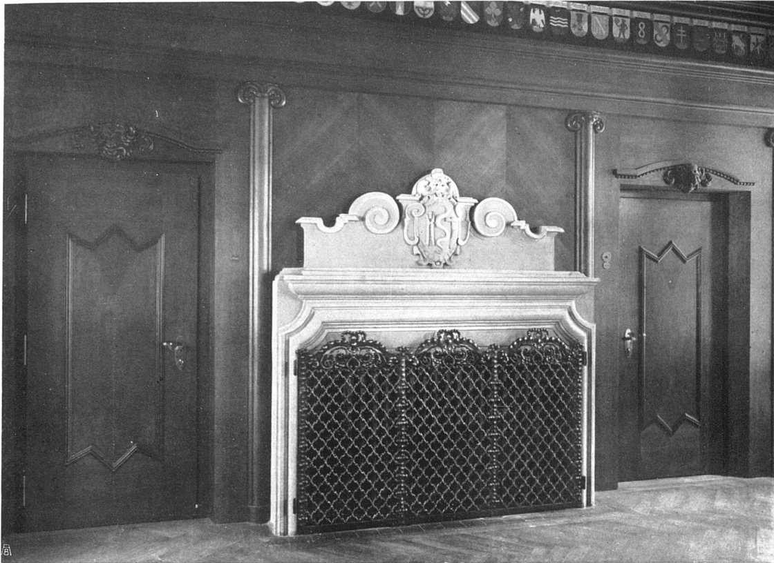
Alter Kamin als Heizkörperverkleidung im Zimmer der Waisenkommission der Zunft zu Schmieden in Bern. Gitter von Niederhäuser & Cie., Bern
