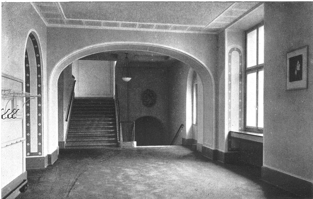
Korridor im dritten Stock und Ausgang zum Singsaal
