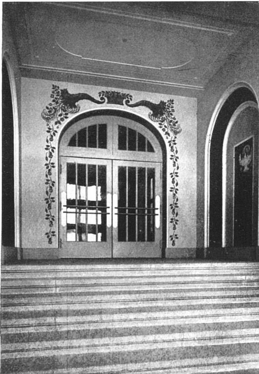
Vestibül auf der Nordseite
