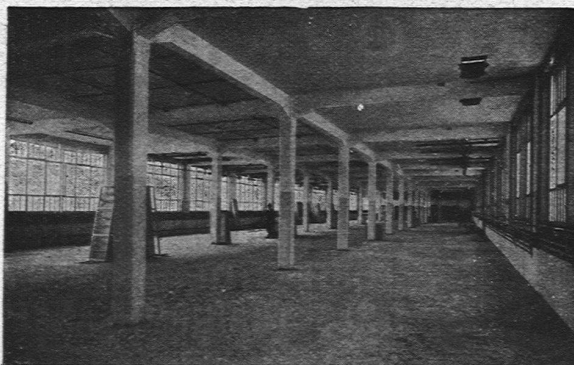
NEUE FABRIKANLAGE C.F. BALLY A.-G., SCHÖNENWERD 12000 m 2
