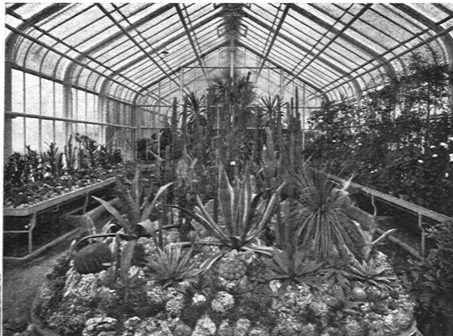
Stadtgärtnerei St. Gallen, beheizt mit Catenakessel
