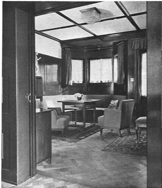
Wohnraum mit Eternit-Deckenfüllungen
