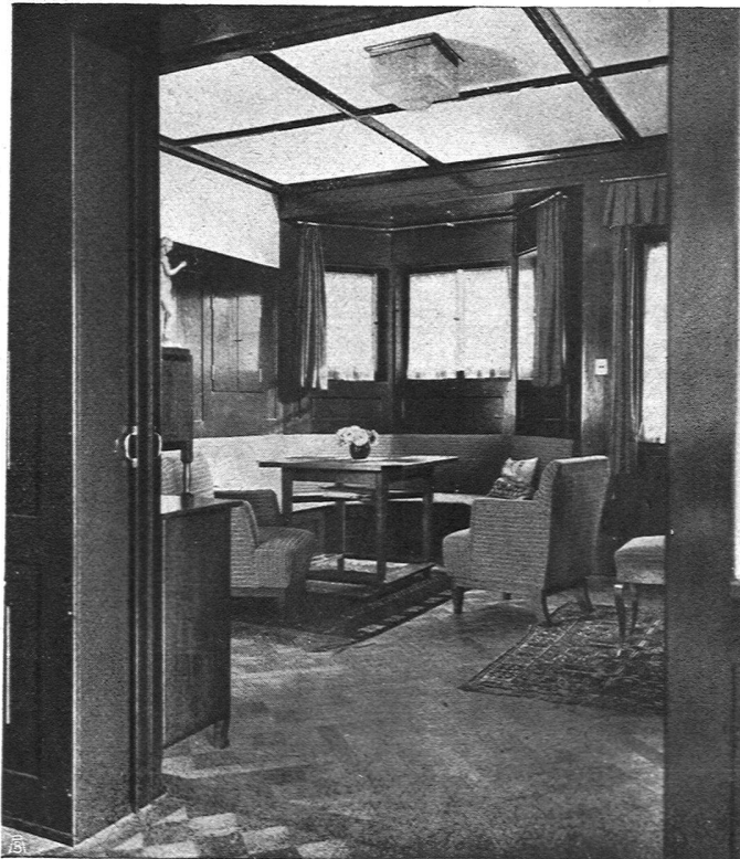
Wohnraum mit Eternit-Deckenfüllungen
