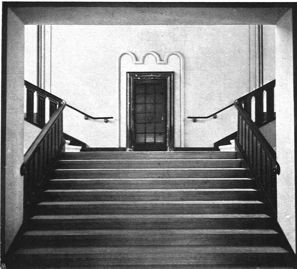
Verbindungstüre zwischen Verhöramt und Zellenbau
