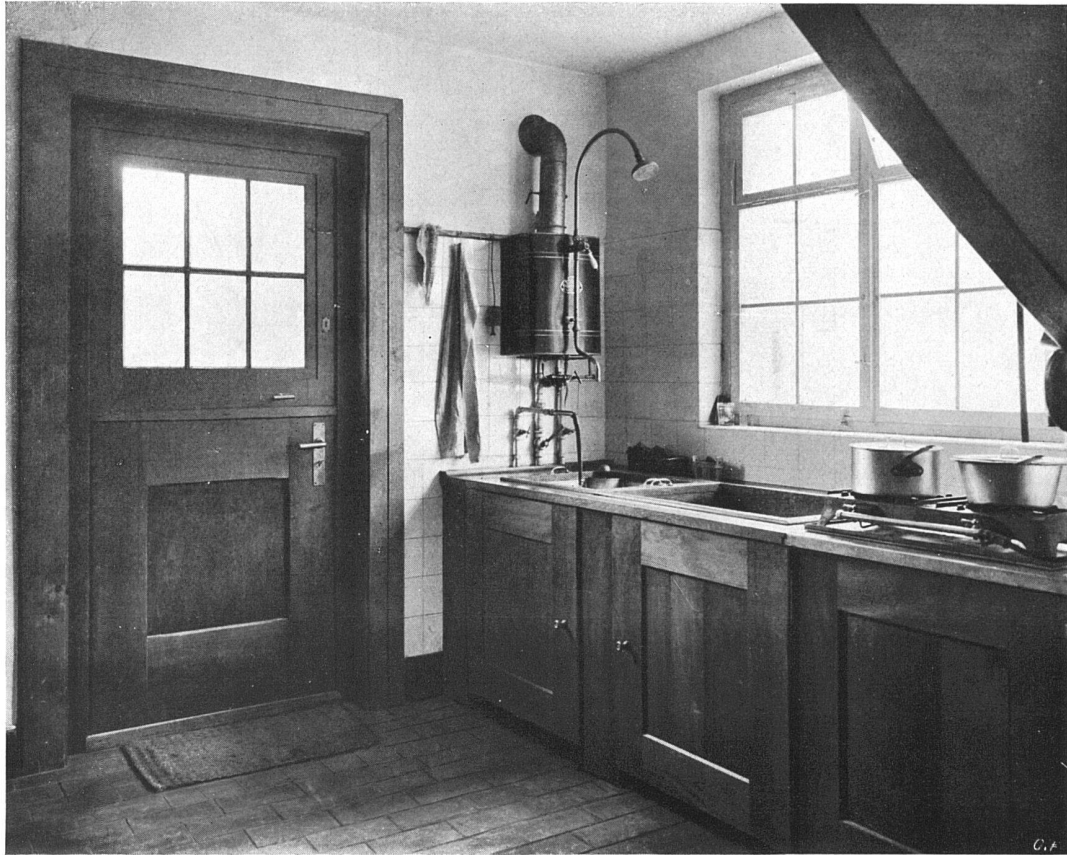
Küche im Wohnhaus Dr. Grob. Gaskochherd, darunter Waschherd. Daneben Spülvorrichtung, darunter Badewanne
