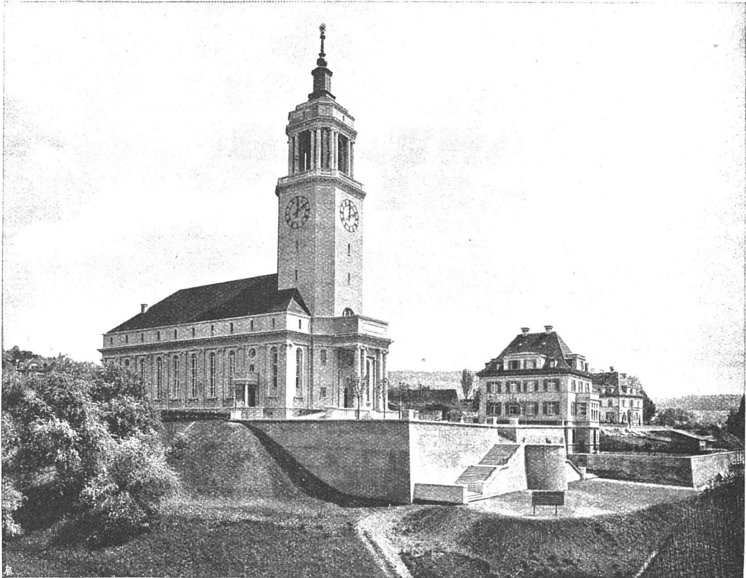
NEUE KIRCHE UND PFARRHAUS IN ZÜRICH-FLUNTERN
