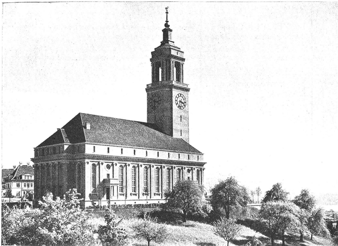
NEUE KIRCHE ZÜRICH-FLUNTERN - BEHEIZT MIT STREBELKESSEL
