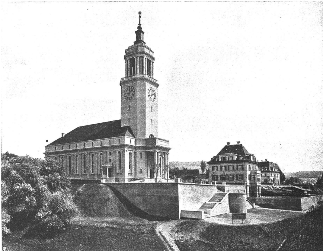
NEUE KIRCHE UND PFARRHAUS IN ZÜRICH-FLUNTERN
