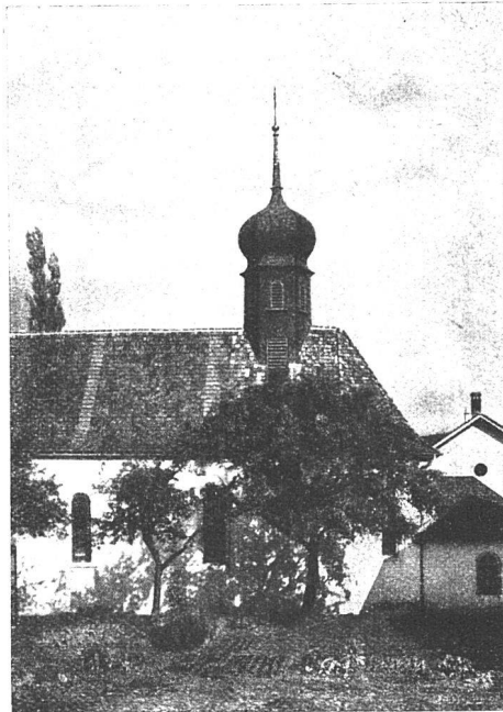
KAPELLE IN SPREITENBACH (AARG.), DACHREITER IN ETERNIT, GESCHLAUFTE DECKUNG, KUPFERBRAUN
