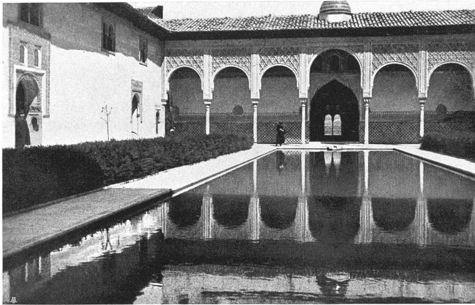
Alhambra, Granada, Myrtenhof; jetziger Zustand Photographische Aufnahme von Architekt C. F. Krebs i. F. Möri & Krebs, Architekten B. S. A., Luzern
